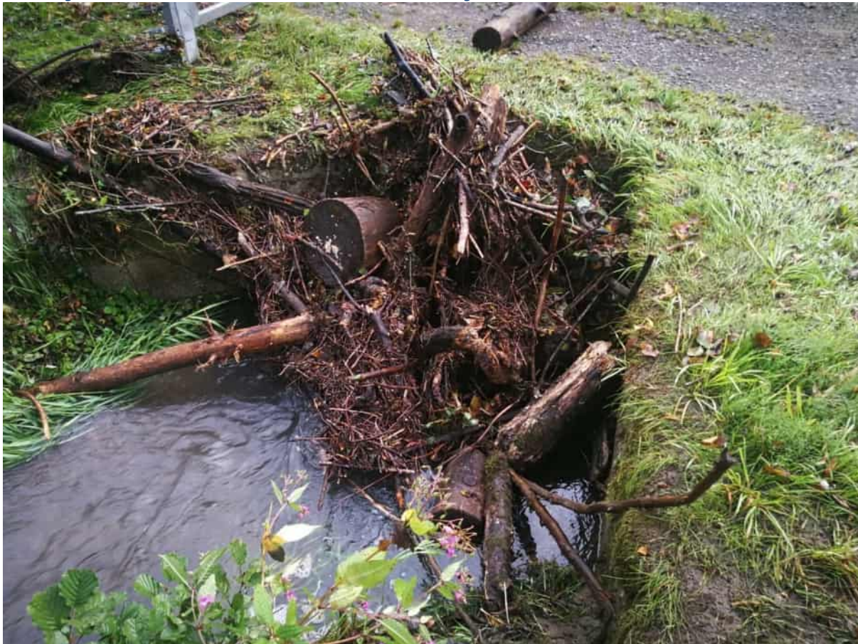
Abbildung 2.6: Verklauter Durchlass Seelbach in Dies
