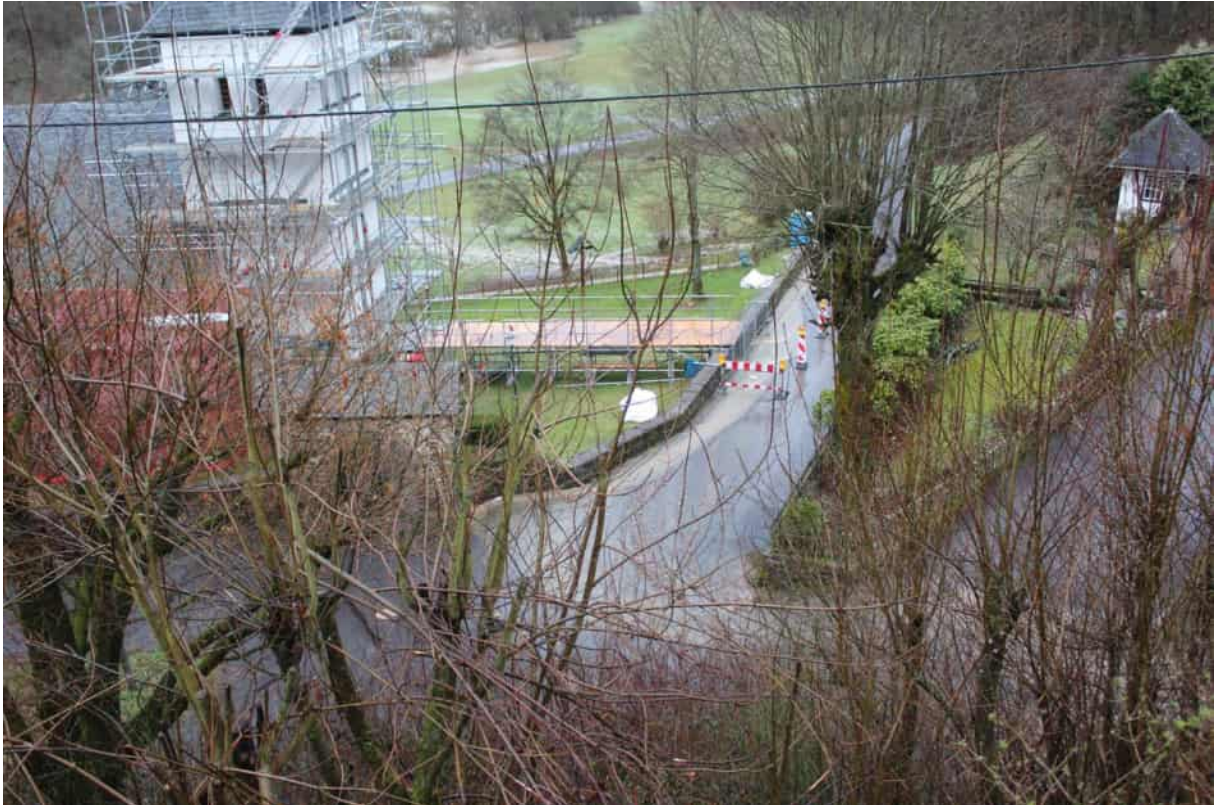
Abbildung 2.9: Übergelaufenes Einlaufbauwerk Kirchährer Bach in Kirchähr
