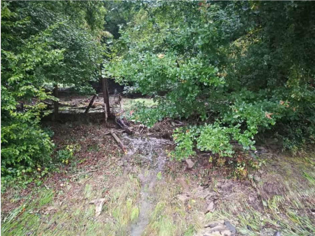
Abbildung 2.11: Beschädigtes Gehege Wildpark Gackebach
