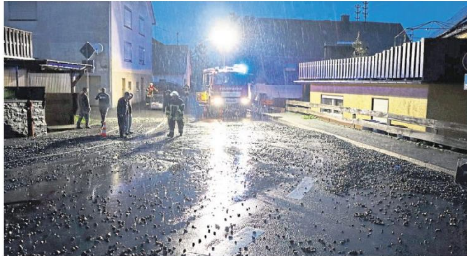
Im Ort Derschen, südlich der Stadt Daaden (Kreis Altenkirchen) gelegen, ist in der Nacht auf Montag durch die starken Regenfälle eine Menge Splitt auf die Straße gespült worden.
