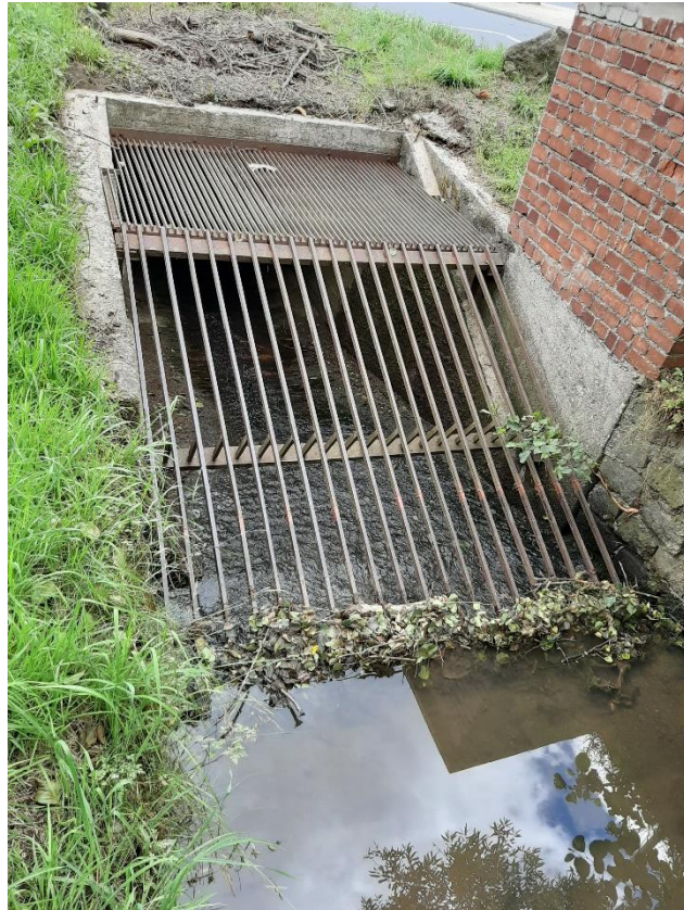
Abbildung 12: Einlaufbauwerk Verrohrung Stadtbach, Fröschpfortstraße Montabaur
