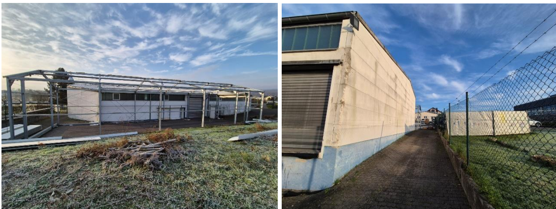
Abbildung 4: Links - Blick auf die nördliche Gebäudeseite mit angrenzender Grünfläche. Rechts - Blick auf die östliche Gebäudeseite.
