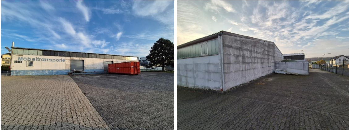
Abbildung 3: Links - Blick auf die südliche Gebäudeseite der Möbeltransport-Firma mit vorgelager-tem Hofplatz. Rechts - Blick auf die westliche Gebäudeseite mit zwei Garagen.
