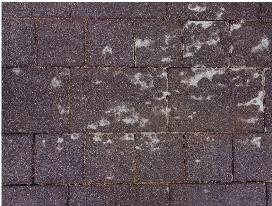
Bild: CityTruck 10 cm, Verlegung 36/24 mit 18/18, Verlegebild
